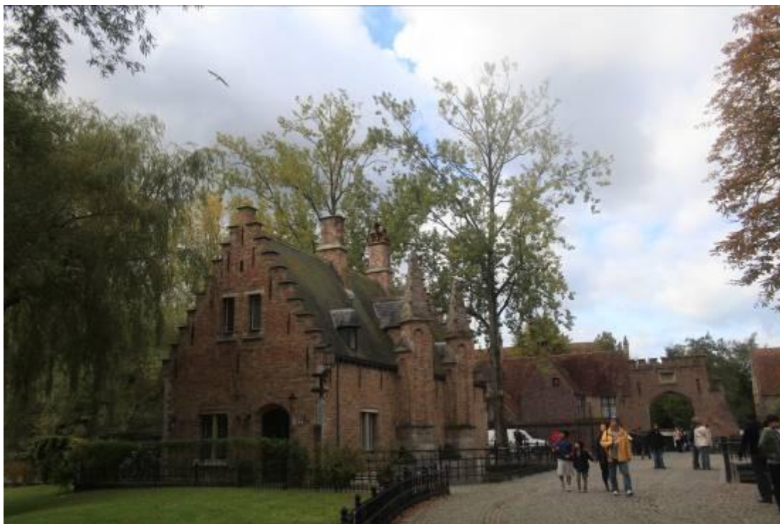
被稱為「布魯日跨度」的建築風格
