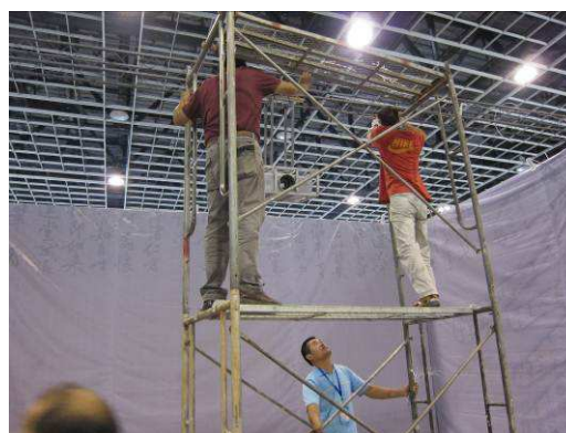
圖 2、施工人員搭建投影機行架。
