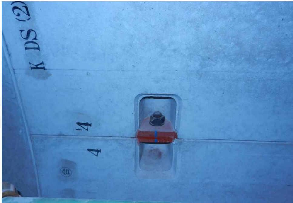
圖 15 洞道環片：片間採用直螺栓接合，環間採用快速插銷式接頭，可提高環片組裝速度及精確度，避免段差之發生。
