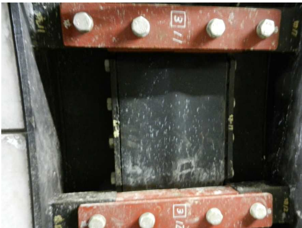
圖 22 完工後可撓式環片構造圖：將連接板拆除，填充發泡橡膠。
