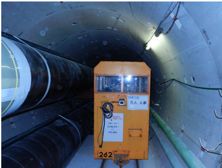
圖 15 洞道環片：片間採用直螺栓接合，環間採用快速插銷式接頭，可提高環片組裝速度及精確度，避免段差之發生。
