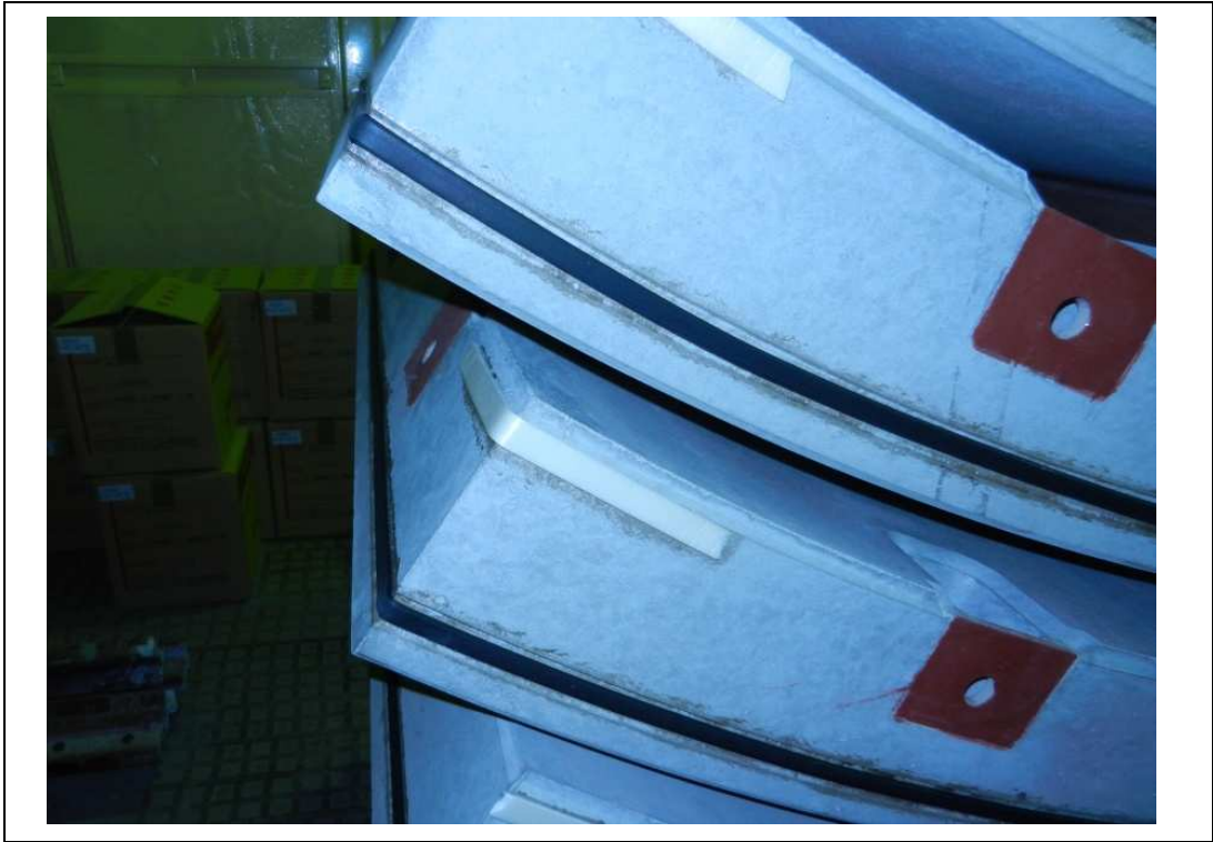
圖 24 洞道環片：採直螺栓銜接。
