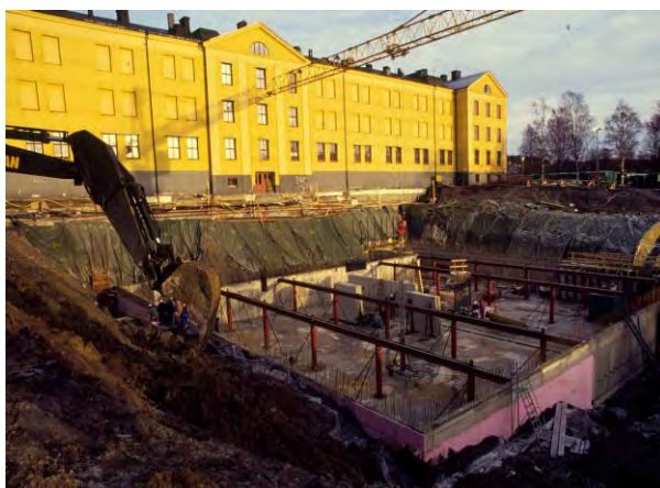
圖 6-4 漢諾桑區域檔案館擴建地下庫房 (來源：漢諾桑區域檔案館簡報檔)
