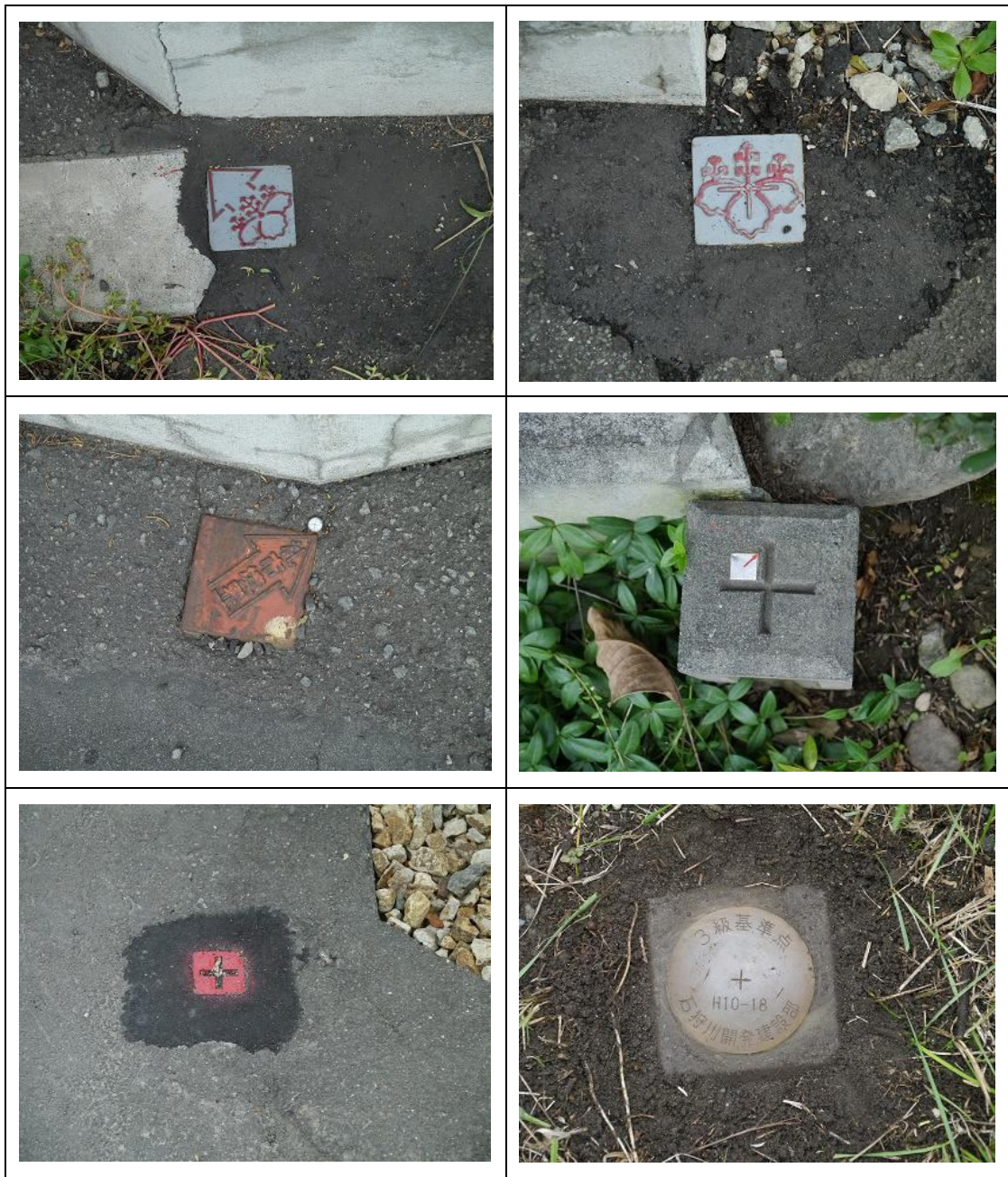
圖 2 札幌法務局南出張所附近實地埋設界標情形
