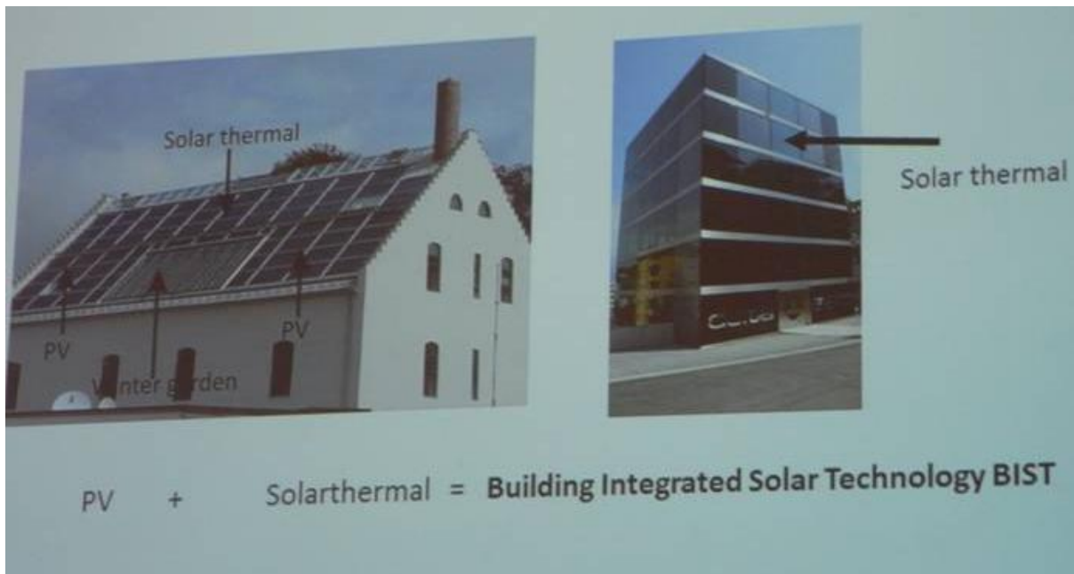
圖 3.94 建物整合太陽能科技(PV+solar thermal)
