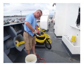
圖 13. 固定器磨平抛光作業
