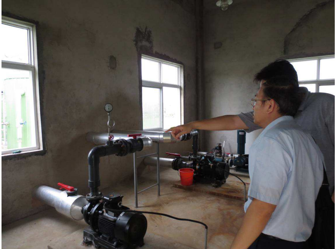
圖 18 脫硫循環泵及脫硫鼓風機
