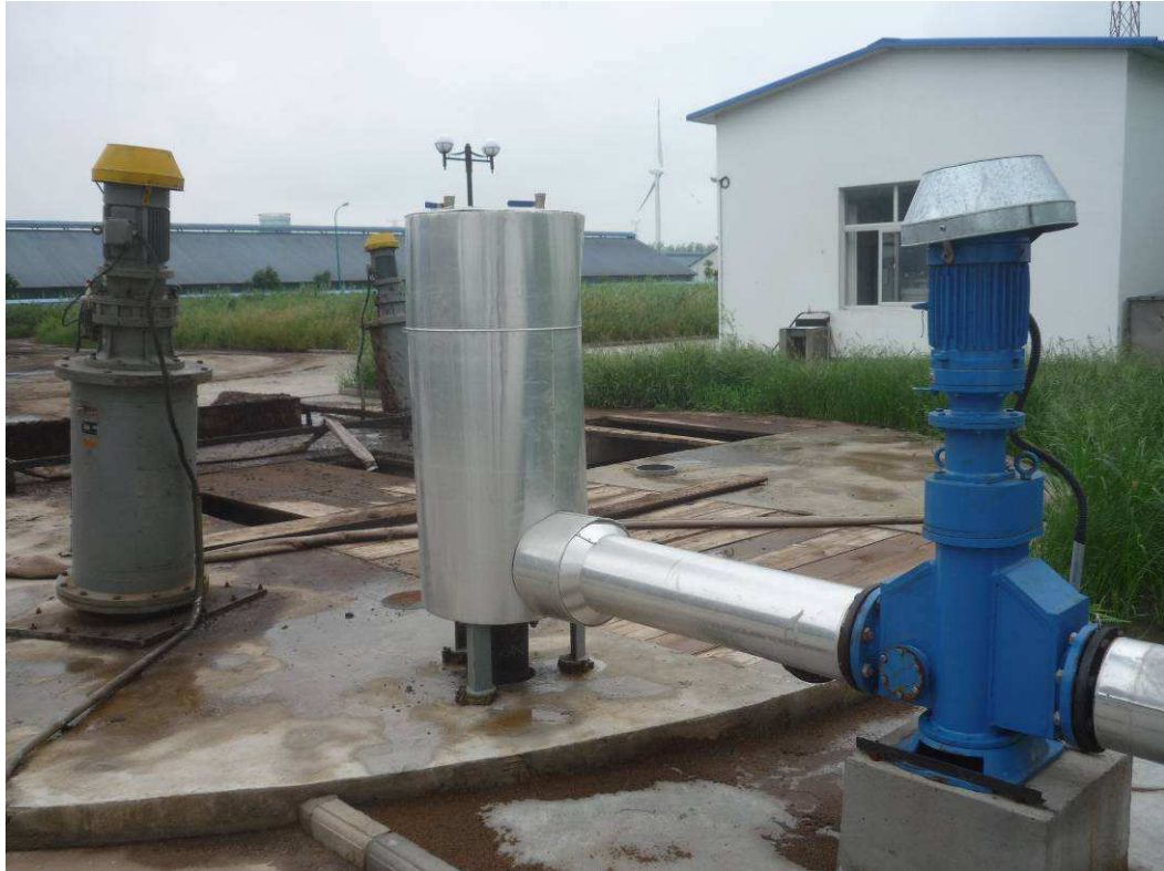
圖 26 牛糞入口處及絞碎機具
