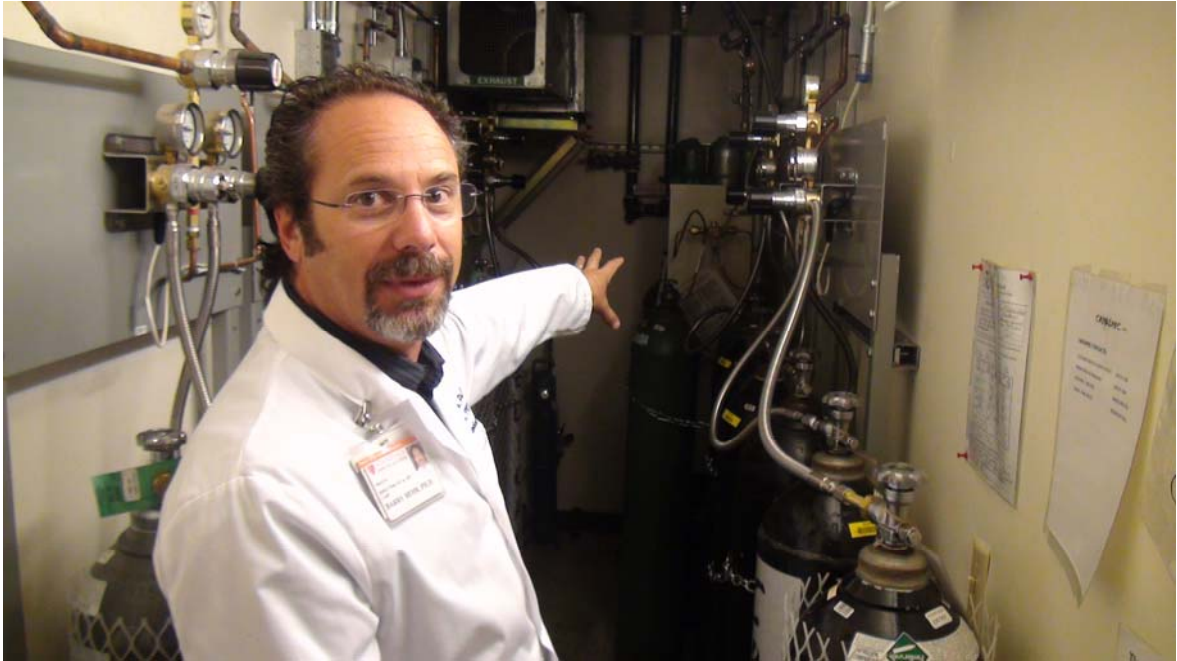
圖三、史丹佛生殖醫學中心的氣體供應室。所有的氣體鋼瓶都連有備用鋼瓶，以維持培養箱的穩定性。圖左為 Dr. Barr Behr。
