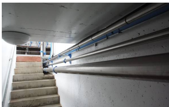
圓盤旋轉式擠乳系統內圈低配集乳管線
