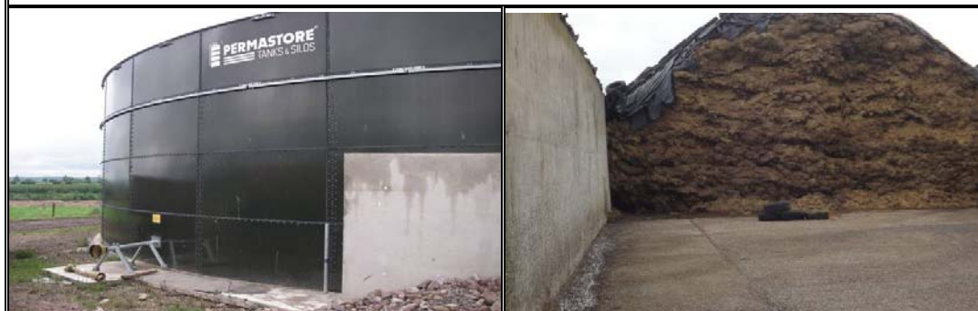
愛爾蘭乳牛場設施-牛糞尿儲存槽及壕溝式青貯窖
