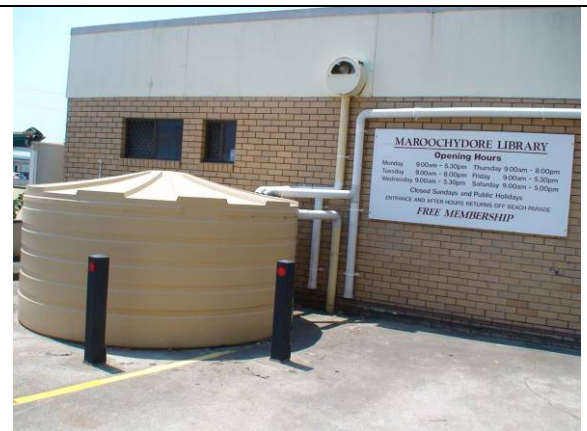
圖 34: 陽光海岸棉樹社區圖書館設置雨水箱，作為公共廁所的替代水源。
