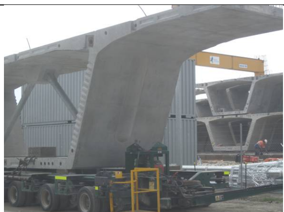
圖 54：南路高速公路預鑄混凝土節塊運輸作業
