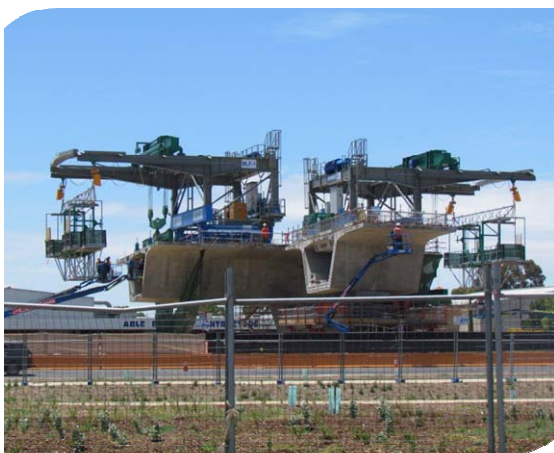
預力節塊吊裝(南澳州政府提供)
