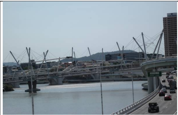
圖 2：跨越布里斯本河之特殊造型人行橋
