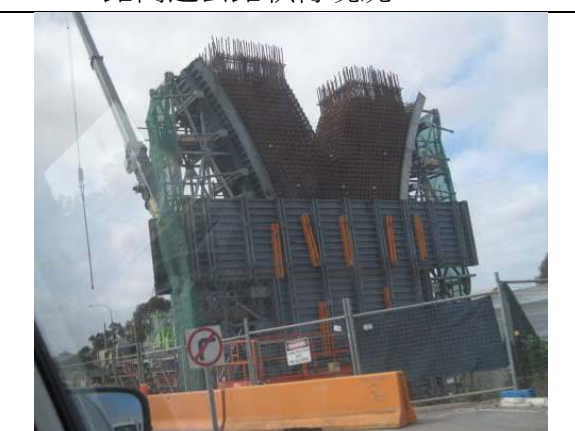
圖 52：南路高速公路橋墩組模
