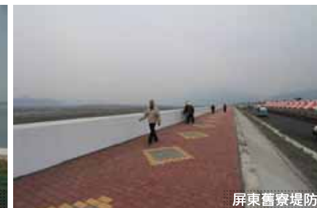
屏東舊寮堤防
