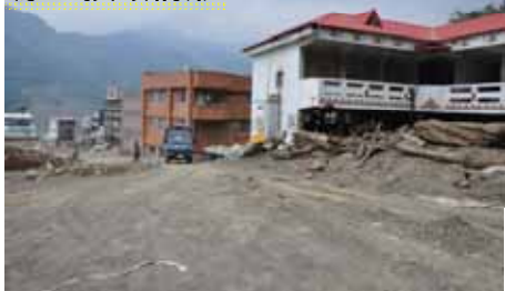
原址損壞情形
