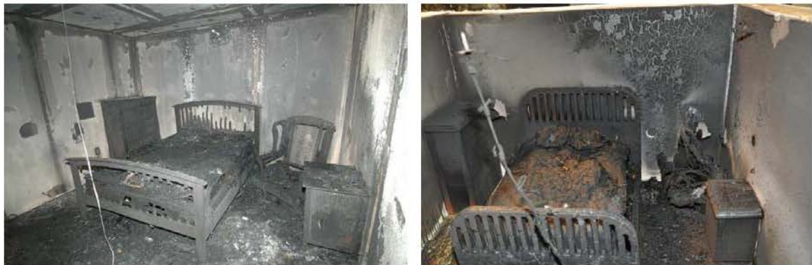
圖11 在床邊右側有一由沙發椅向上之V型燃燒痕跡
