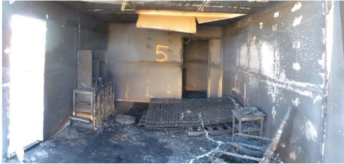
圖 22 臥室燃燒後狀況
