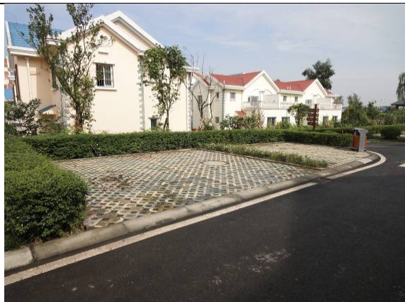
圖 9：南新村停車場以植草磚鋪設，增加建築基地保水性，符合綠色生態概念
