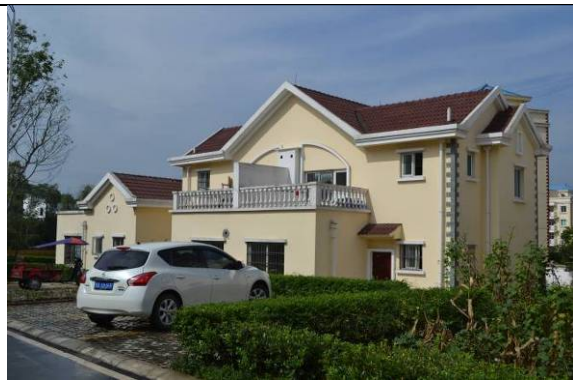
圖 6：南新村房屋建築風格採歐式造型
