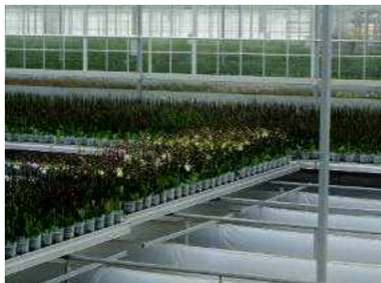
圖 32. 冷氣在床底避免與熱空氣混合
