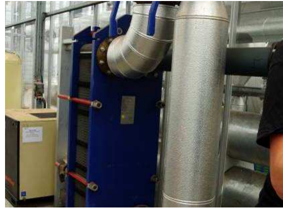
圖 36. 板式熱交換機用地下水熱交換
