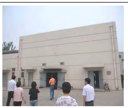
氣體滅火試驗館
