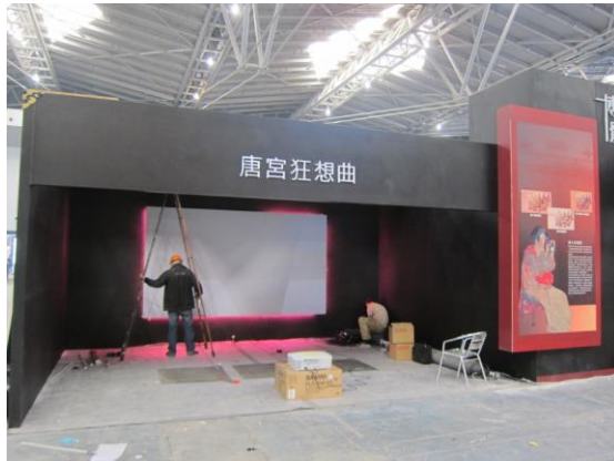
左圖 5：唐宮狂想曲互動區設備架設情形
