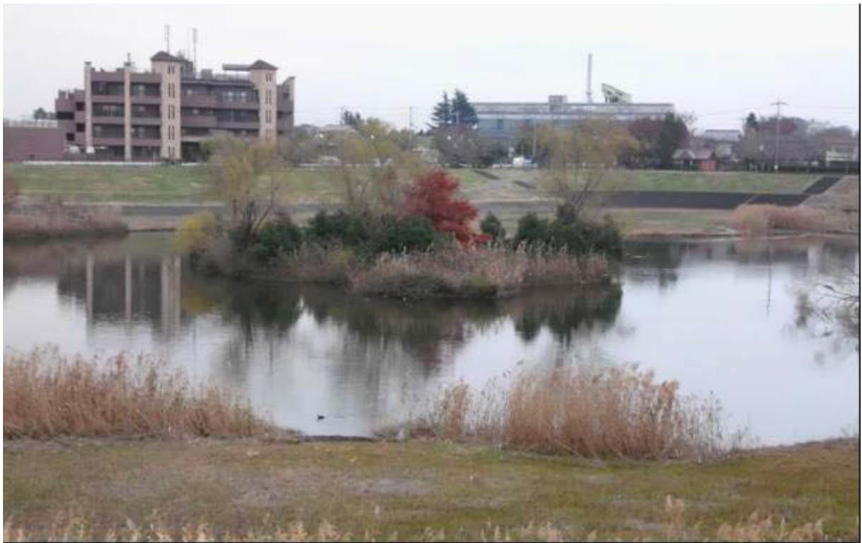
圖-16 大吉調節池興建工程
