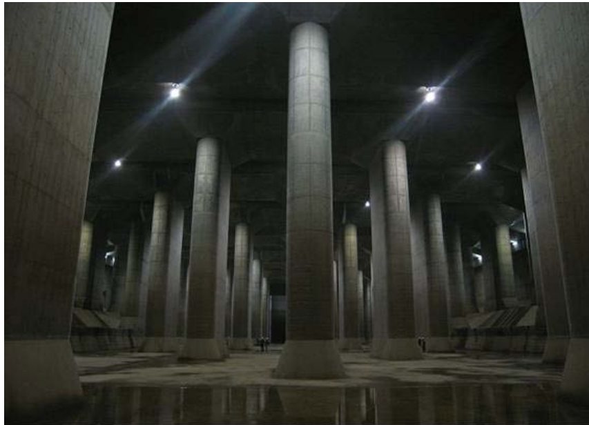
圖-10 59 根混凝土巨柱撐起之大型地下調節池
