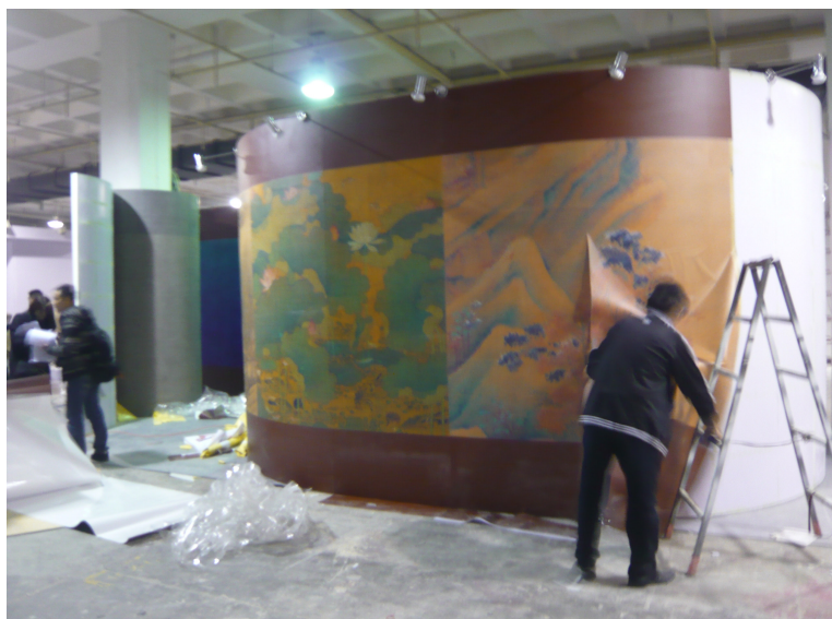
圖 2 至 4：11/8，廠商於展場木作與裝潢施工情形
