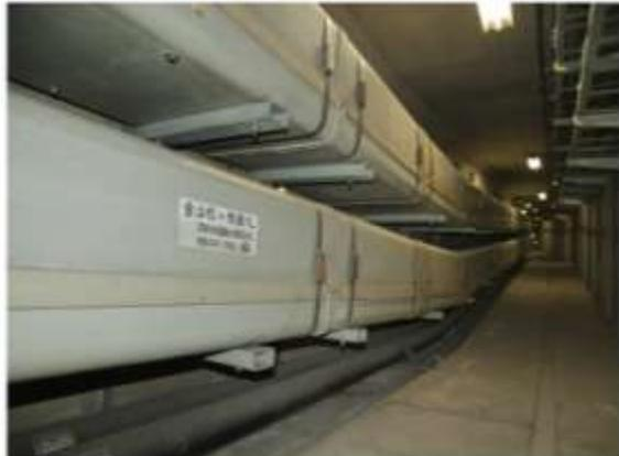
圖七：洞道內線槽
