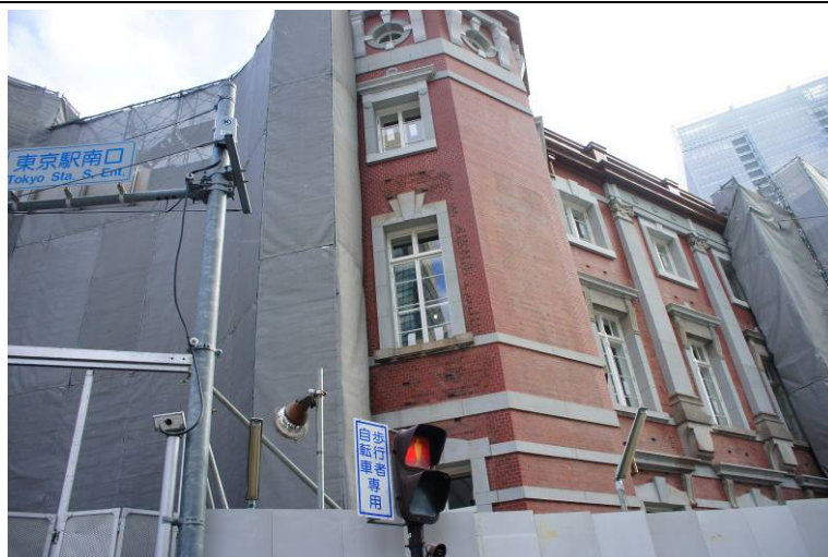
東京車站建築物節能改造
