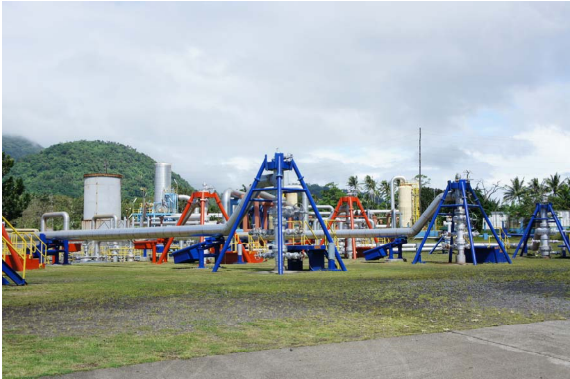
圖 1：Mak-Ban 地熱電廠之地熱產生井群
