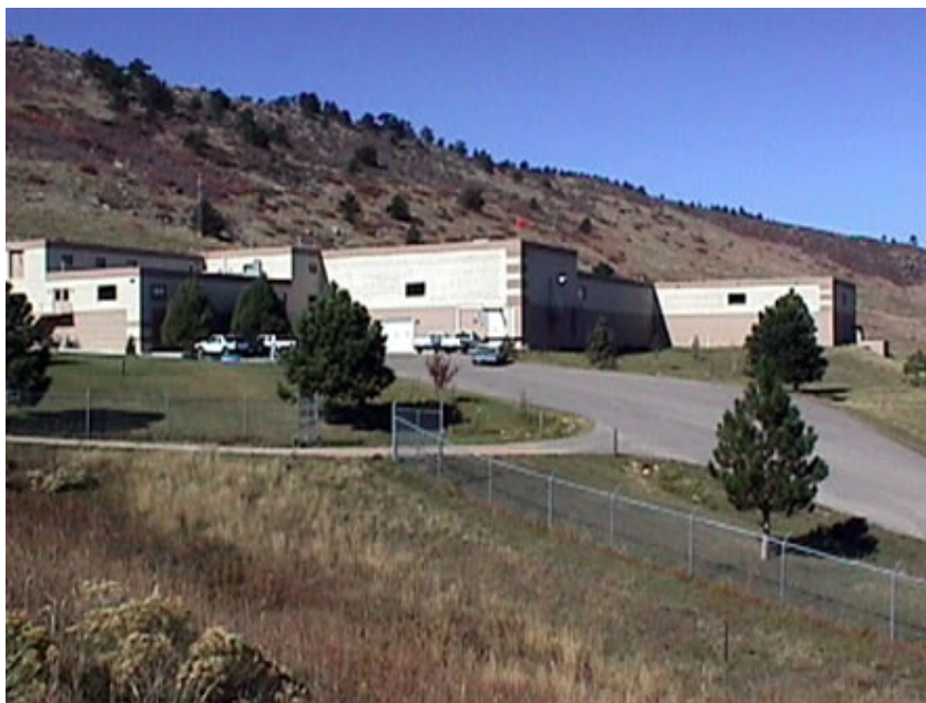
圖 5.Soldier Canyon Filter Plant 外觀(全部處理設備均於室內)
