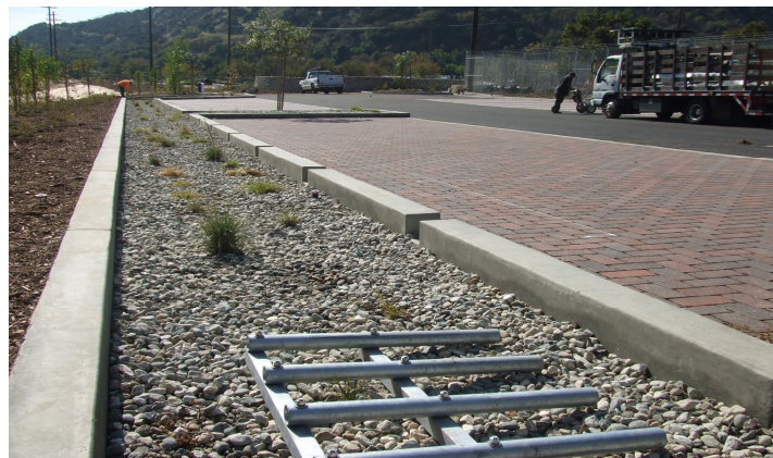
圖 17 鋪設透水鋪面增加雨水入滲
