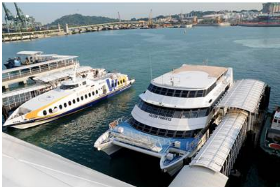
圖 2.42 新加坡區域渡輪碼頭（RFT）
