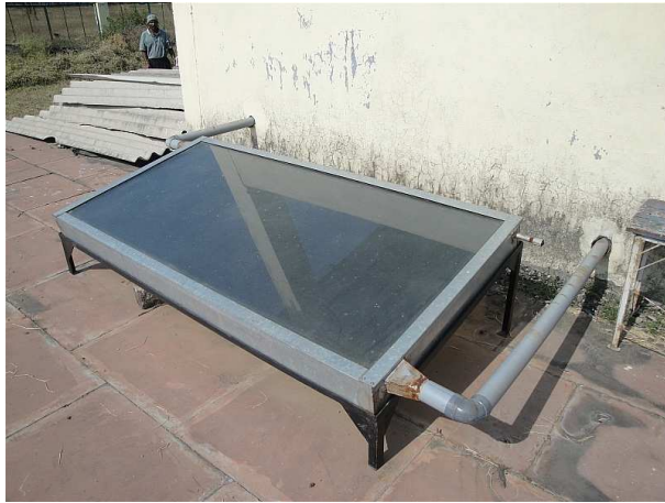
圖 24 太陽光吸收加熱板
