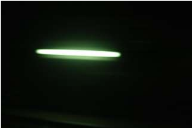
照片19：仁川機場鐵路隧道照明節能僅開啓1/3
