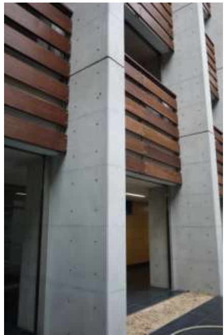
照片50：松島國際學校採用耐久堅固之環保材質及清水模板牆面減少裝修
