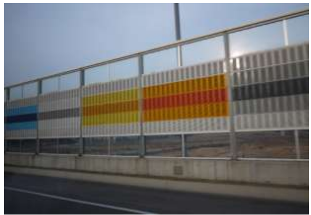
照片10：首爾至仁川高速公路旁隔音牆(高約5公尺)
