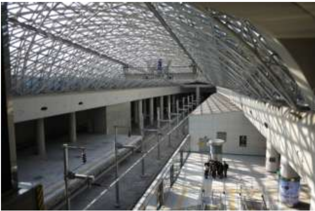
照片21：仁川機場鐵路大型車站自然採光及自然通風
