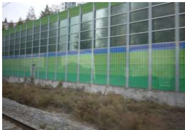
照片58：KTX(韓國高鐵)夾有透明板之隔音牆(約10公尺高)
