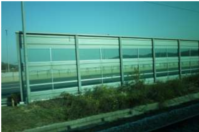
照片15：仁川機場鐵路夾透明板型隔音牆(高約3公尺)
