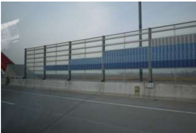
照片9：首爾至仁川高速公路旁隔音牆(高約5公尺)
