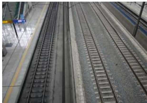
照片64：KTX道碴軌道(右)及韓國國鐵版式軌道(左)
