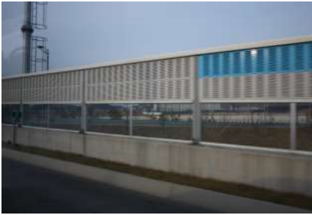
照片7：首爾至仁川高速公路旁隔音牆 (高約3公尺)
