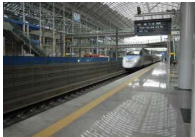
照片62：KTX(韓國高鐵)光明車站穿越線隔音牆(約3公尺高)
