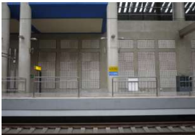
照片65：光明車站部份區域貼有吸音材減音
