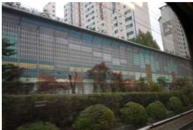
照片60：KTX(韓國高鐵)於首爾市區有高約10公尺隔音牆
