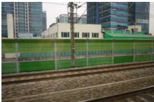
照片57：KTX(韓國高鐵)隔音牆多為3公尺高(頂緣內彎型)
