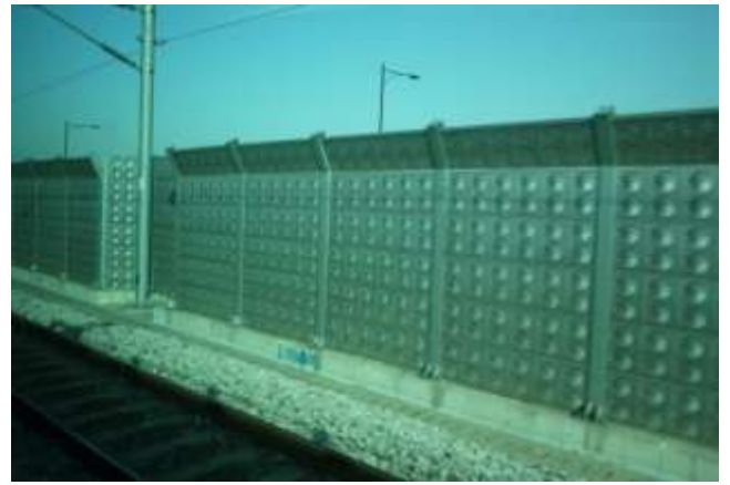
照片14：仁川機場鐵路頂緣內彎型隔音牆(高約3公尺)
