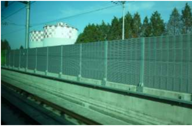
照片13：仁川機場鐵路直立型隔音牆(高約3公尺)
