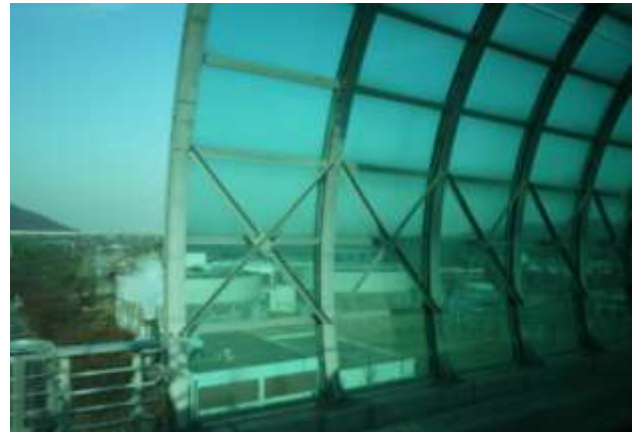
照片16：仁川機場鐵路全罩式隔音牆
