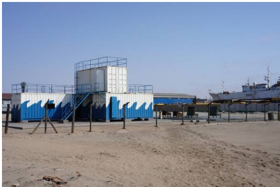
Pic.13 NAMFI 滅火訓練場
