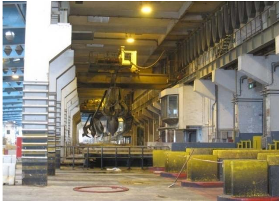
(3) 垃圾傾卸平台。
