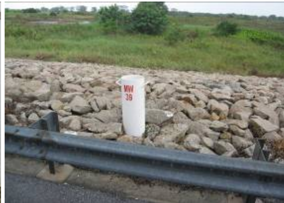
(5) Semakau 掩埋場場內護岸實景。(6) 場內設置水質觀測井監測滲出情形。
