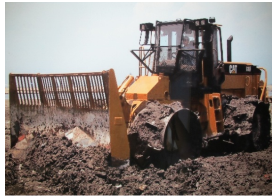
(2) 推土機碾平夯實作業情況。
