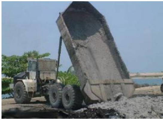
(1) 傾倒填埋作業情況。
