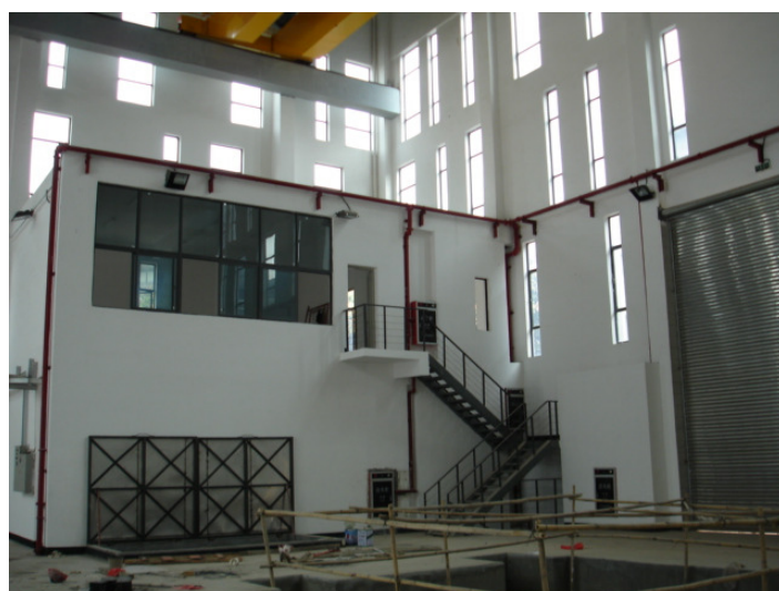
圖 5 施工中的振動台實驗室 資料來源：陳伯勳
