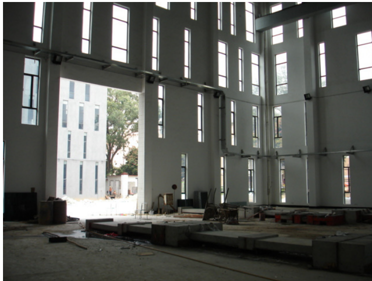
圖 6 施工中的防災減災實驗室內部照片 資料來源：陳伯勳
