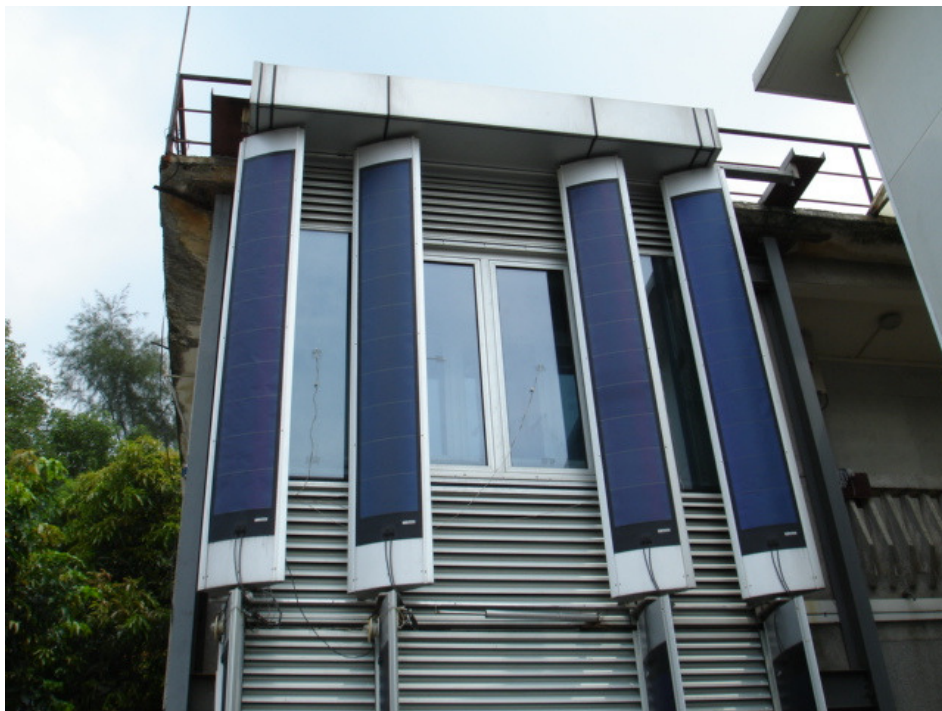
圖 14 太陽能板與遮陽實驗牆體外觀 資料來源：陳伯勳
