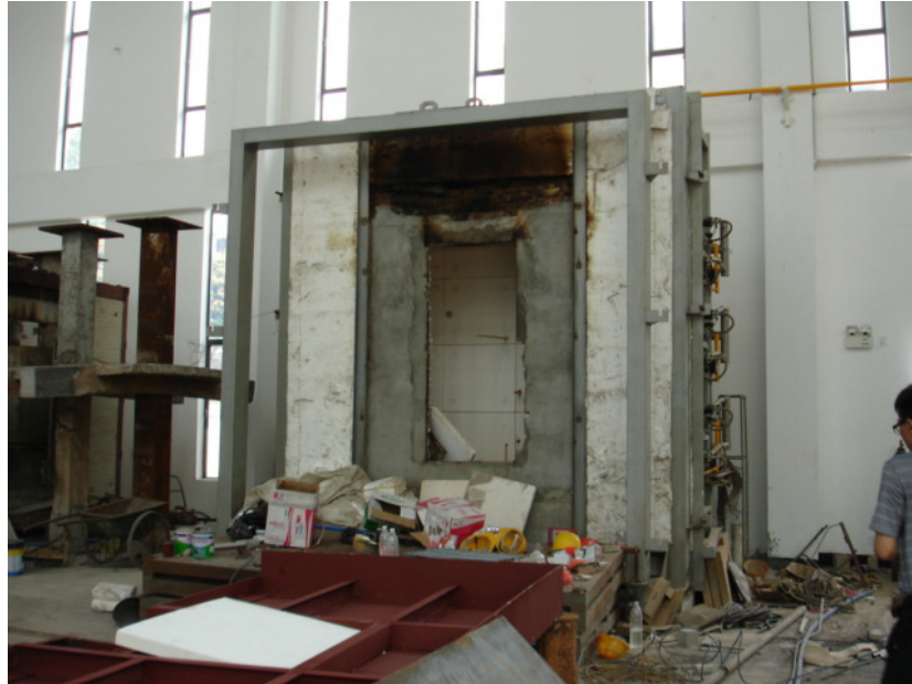
圖 9 施工中的結構耐火實驗室
