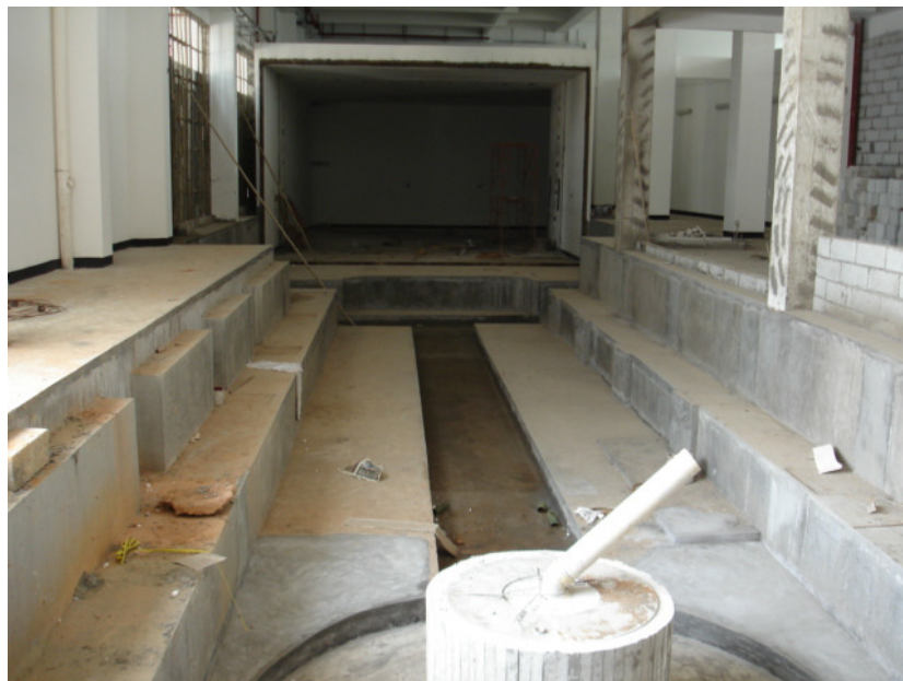
圖 10 施工中的風洞實驗室 資料來源：陳伯勳
