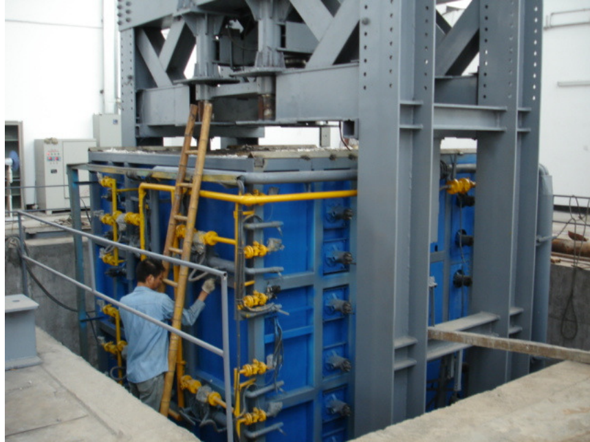
圖 7 施工中的結構耐火實驗室
