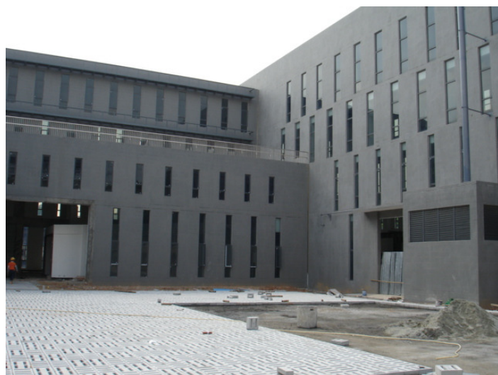
圖 4 施工中的防災減災實驗室外觀
