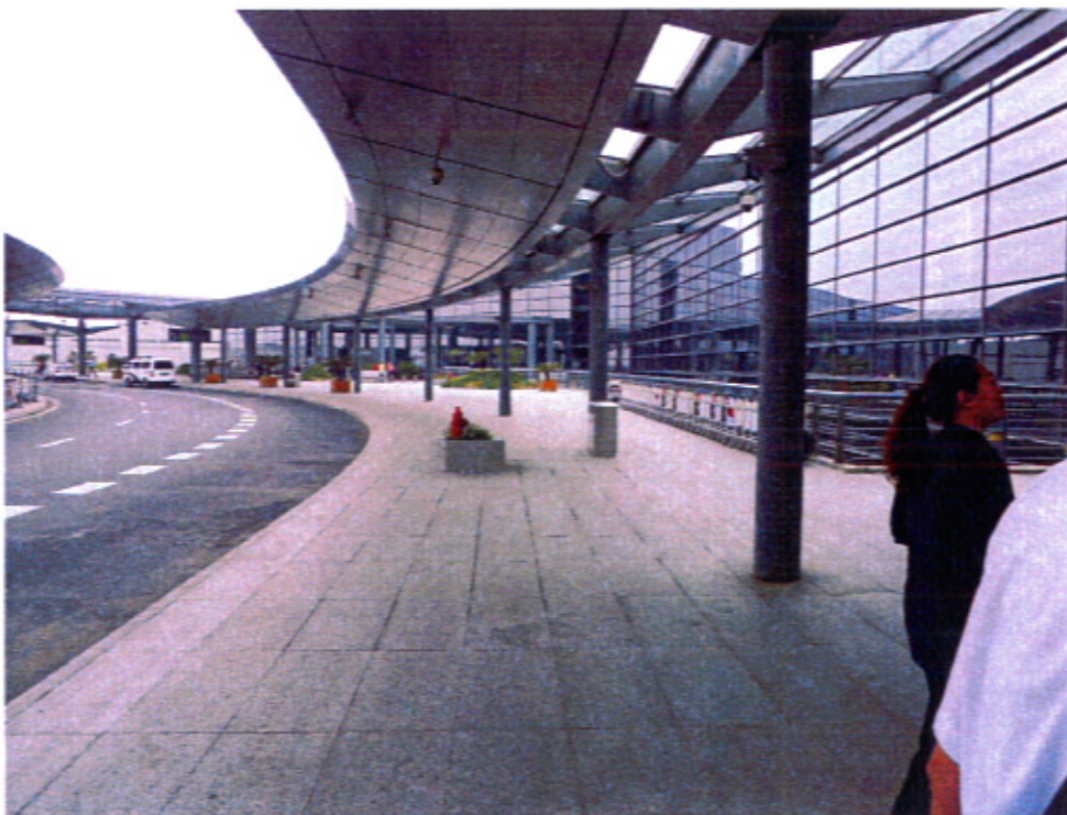
虹橋機場第二航廈外觀簡單明亮
