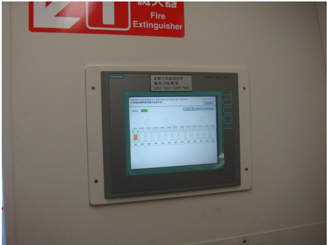
圖 11. 車載行李處理系統之觸控式螢幕
