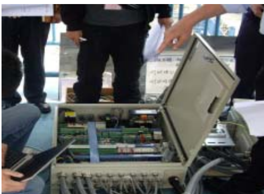
圖 29 馬達及配線之絕緣測試
