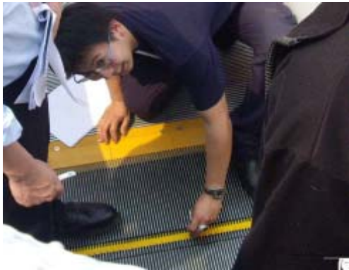
圖 9 量測相鄰兩踏階之間隙
