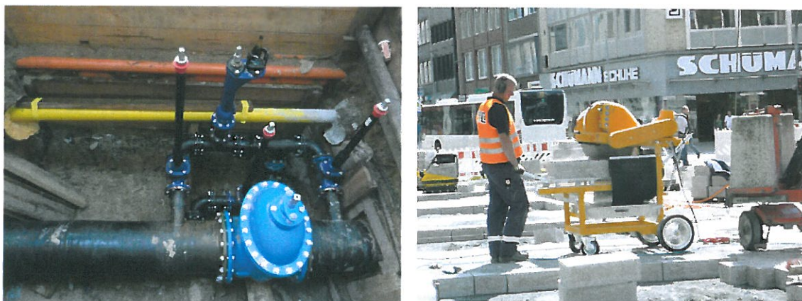
圖 35、整齊的管線與磚鋪設工程
