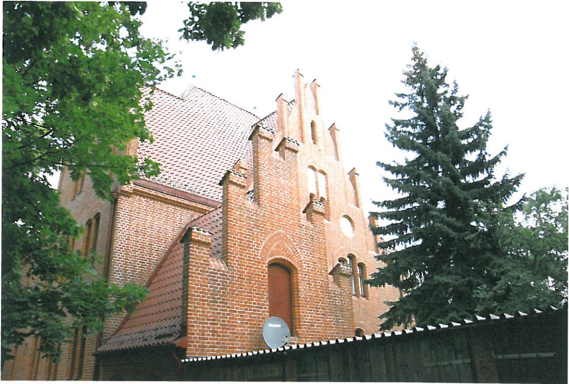
圖 25、維持良好的水廠建築
