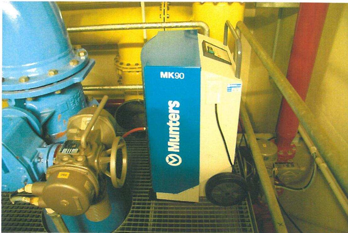
圖 5、大型除濕機去除空氣中濕度
