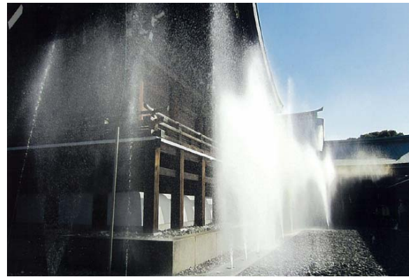
明治神宮撒水幕放水
