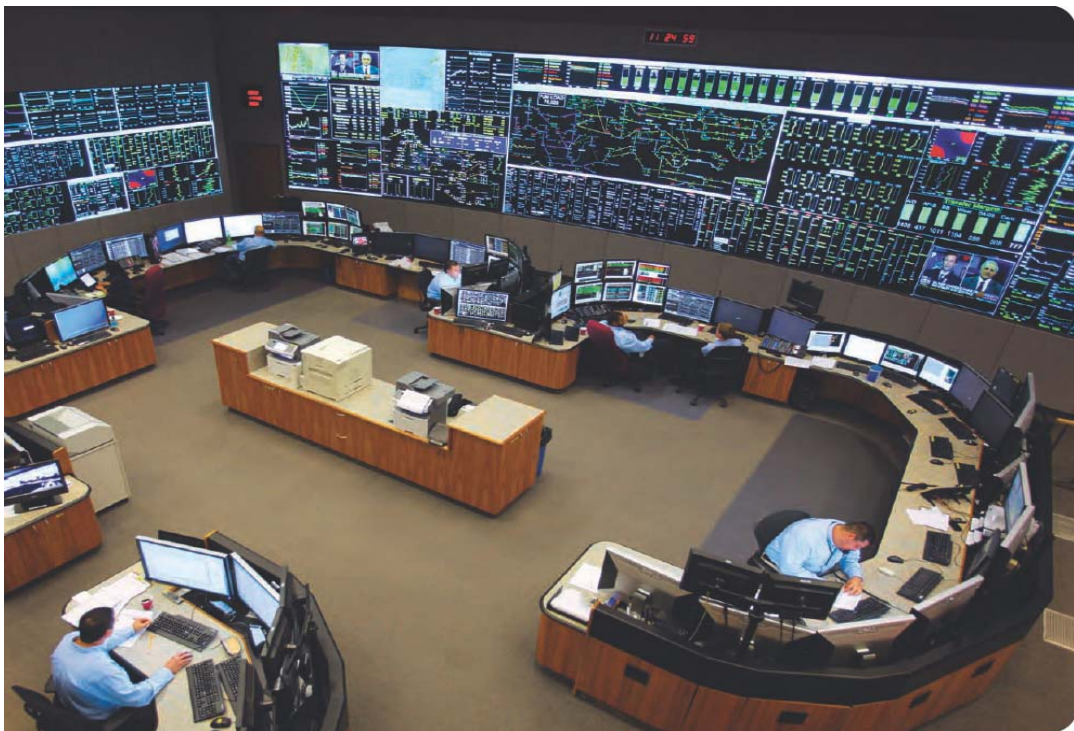
圖 3.8 PJM 調度中心全貌
