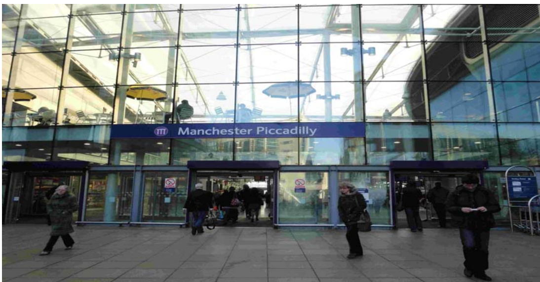
圖 3.70 車站玻璃帷幕外牆
