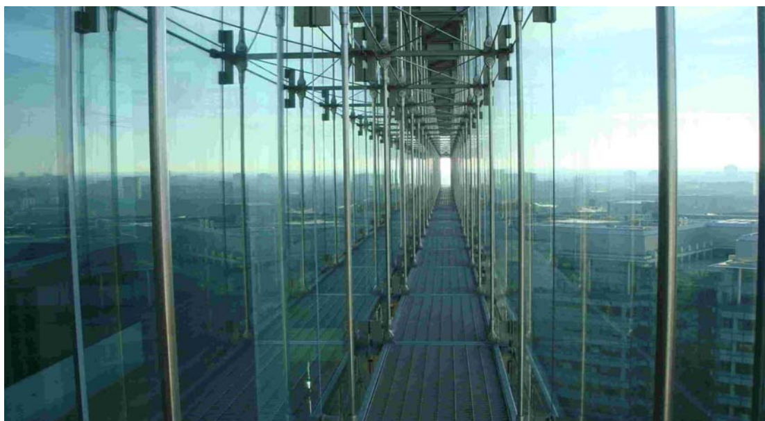
圖 3.77 大樓大廳外牆
