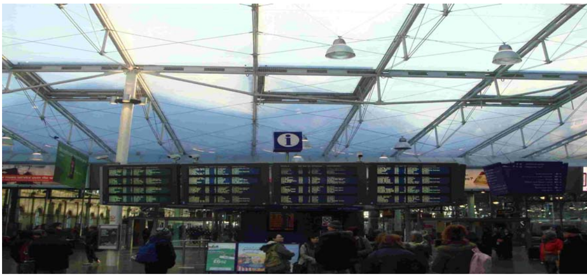
圖 3.68 車站大廳 ETFE 薄膜透光屋頂
