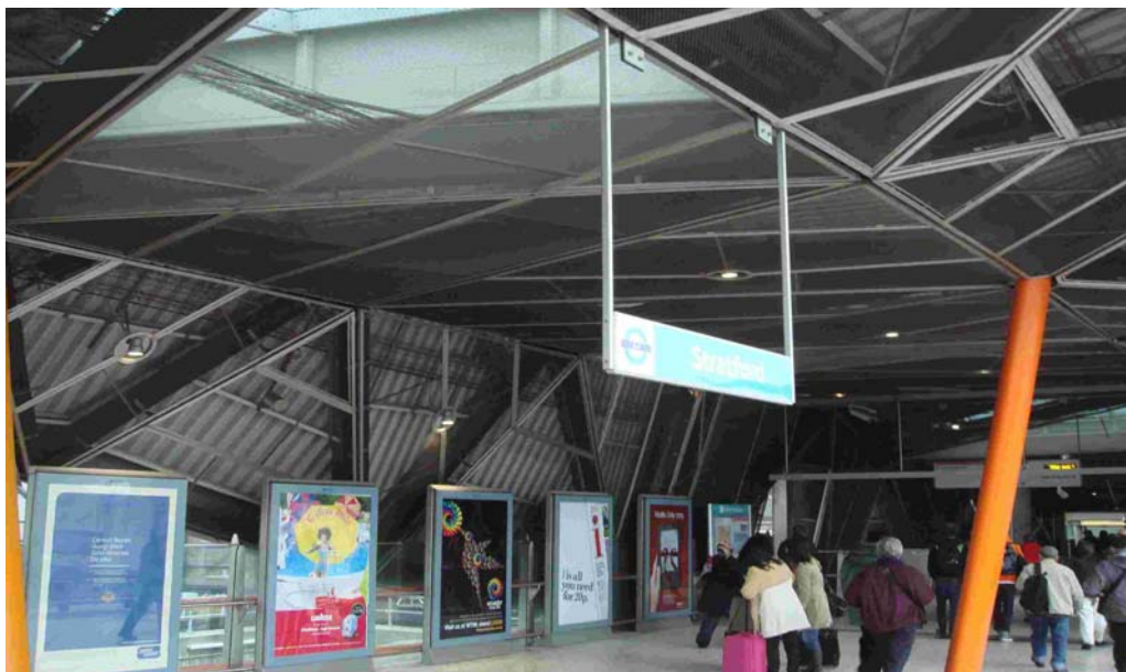
圖 3.65 Stratford 車站透光屋頂
