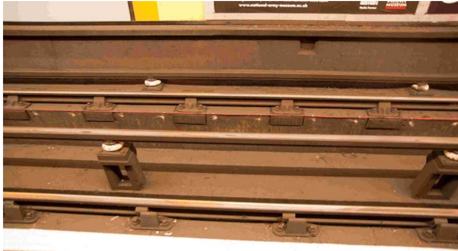
圖 3.14 倫敦地鐵導電軌
