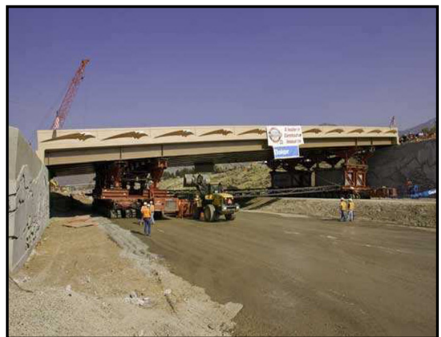
圖 9、利用 SPMT 運放新的上部結構
