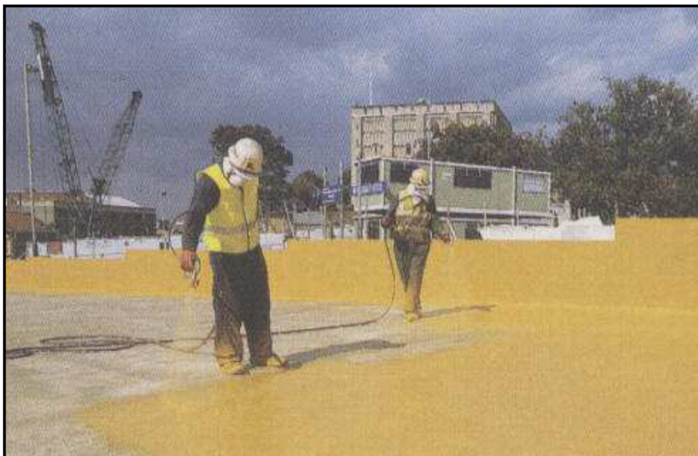
圖 38、橋面防水層之噴塗情形
