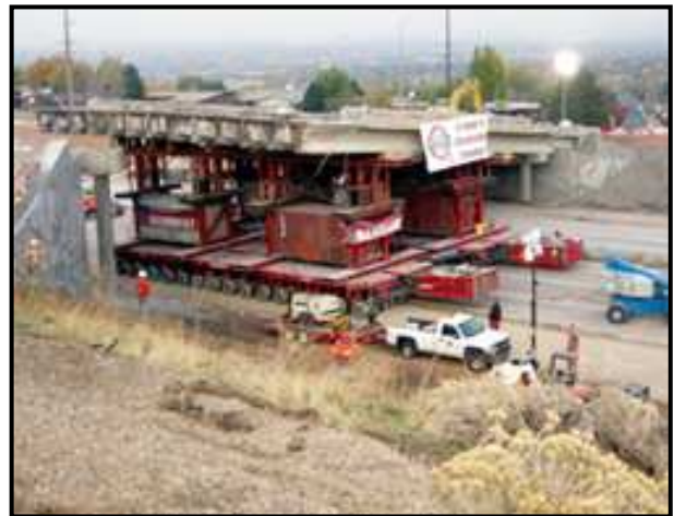
圖 7、利用 SPMT 抬移舊橋之上部結構
