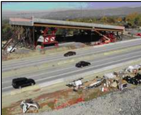
圖 6、在橋址旁利用臨時橋台 搭建新的上部結構
