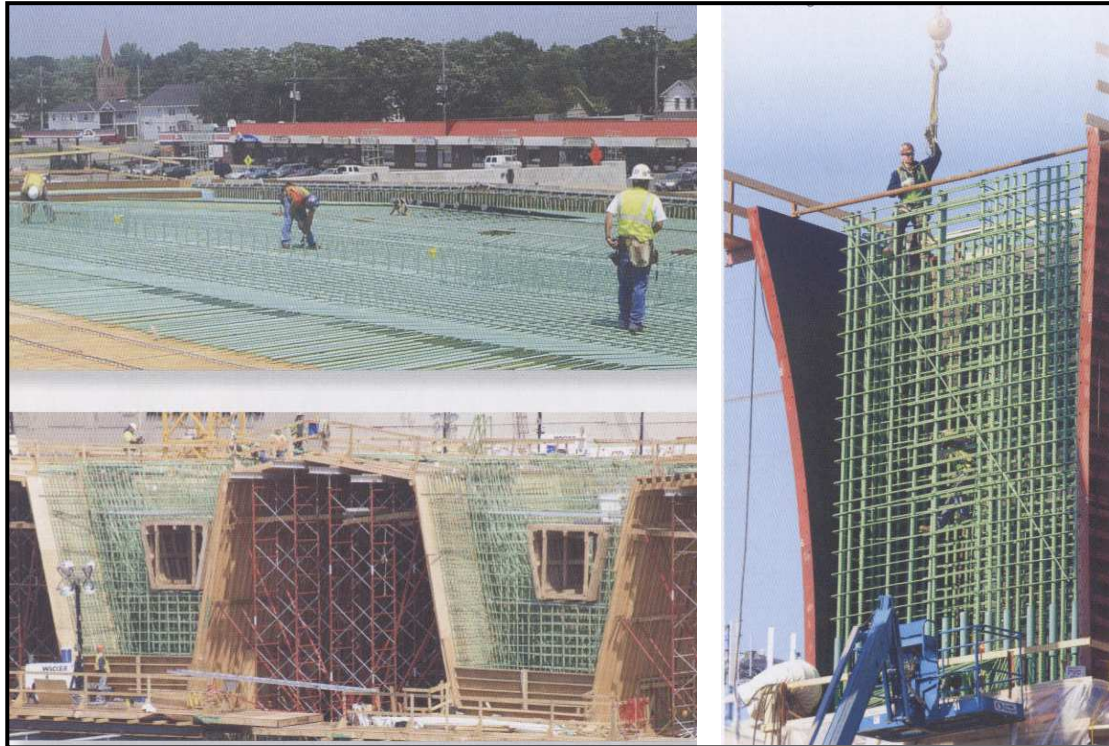
圖 33、環氧樹脂塗層筋應用於橋梁工程之情形
