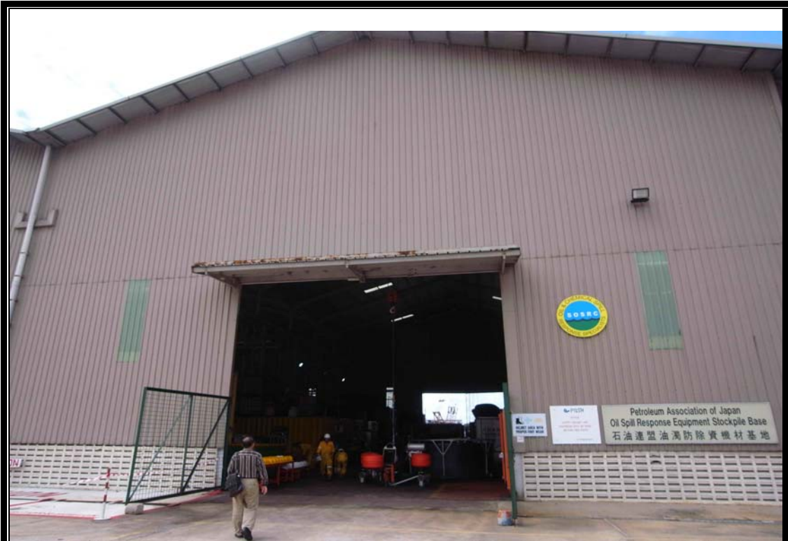
圖一：SOSRC 設備庫
