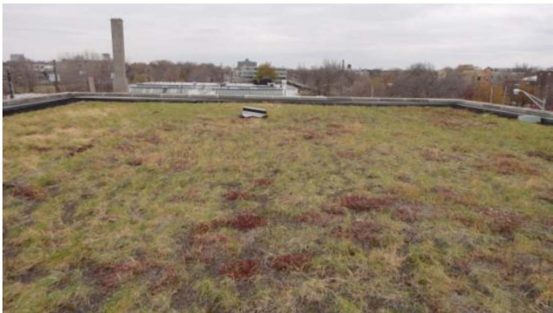
屋頂設置薄層綠化降低夏季空調負荷
