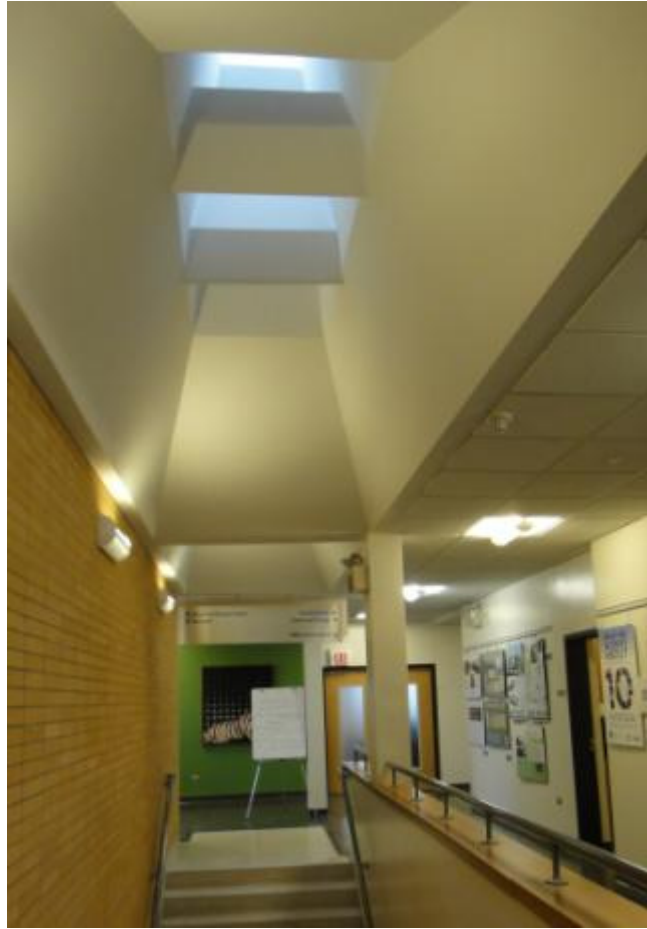
運用天窗自然採光節約能源
