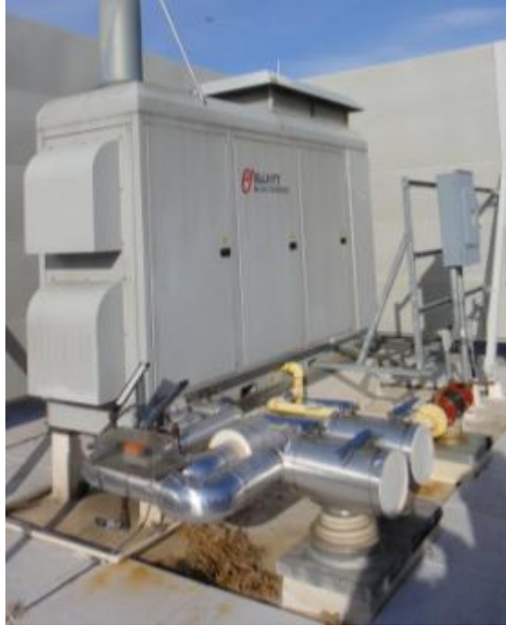
廢熱回收系統降低暖房用電量需求
