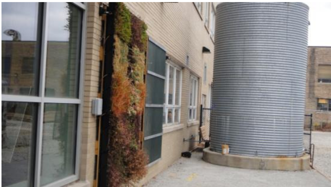
牆面綠化實驗區
