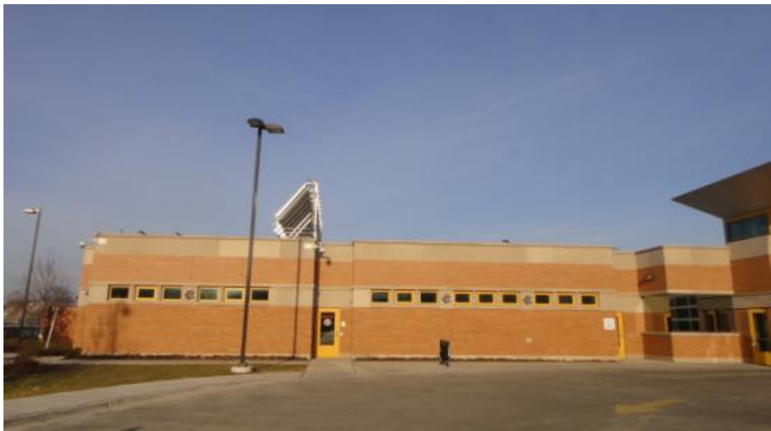
屋頂太陽能熱水器減少原有熱水系統的能源需求
