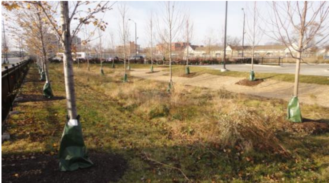
低窪綠地設計使雨水有足夠的貯集滲透空間
