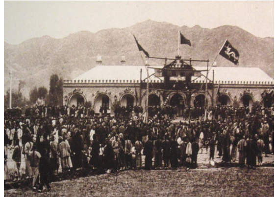
圖 4-20、晚清鐵道車站的落成使用
