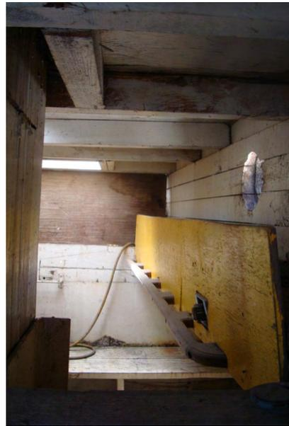
部分水密隔艙板被拆除，加裝現代設備。
