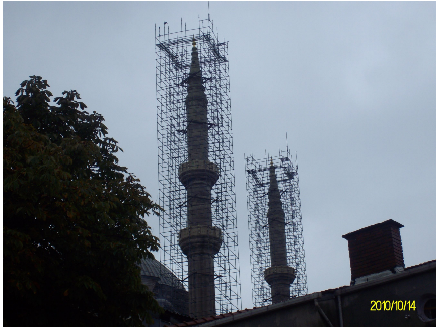
圖 4 古蹟外牆維護情形
