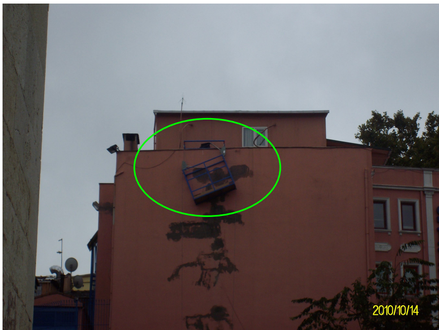
圖 5 大樓吊掛吊籠情形
