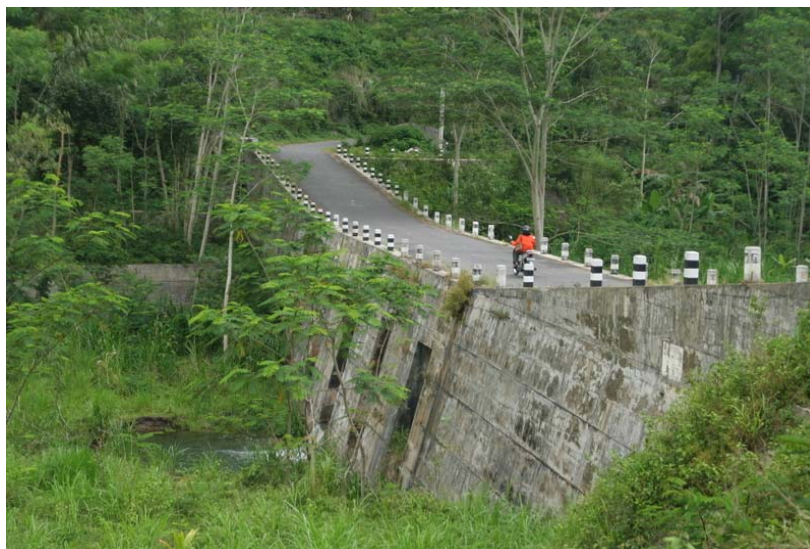
圖 5 防砂壩(與道路共構)
