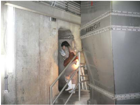
圖 26 機械室往地下隧道入口
