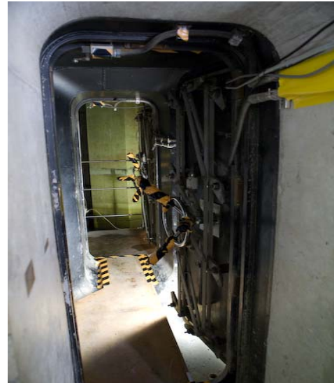
圖 27 機械室往地下隧道連通艙道
