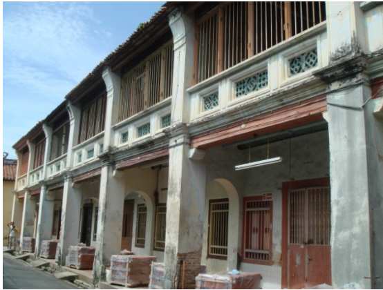
圖：圍繞廣場的街屋群（整修中）
