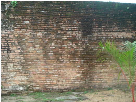
圖：修復的舊圍牆（修舊如舊）
