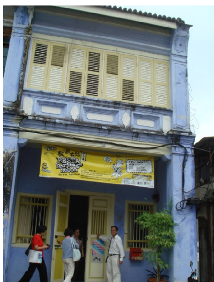
圖：位於修復之舊建物中的城市小孩辦公室
