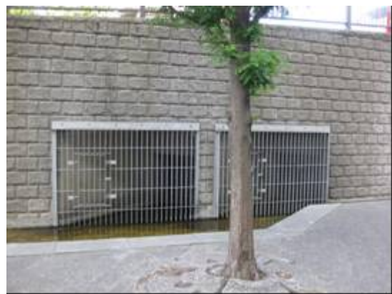
圖 35 妙正寺川第一調節池溢水孔
