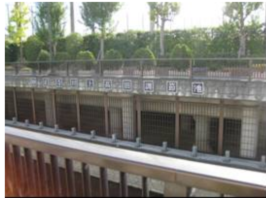
圖 39 妙正寺川上高田調節池
