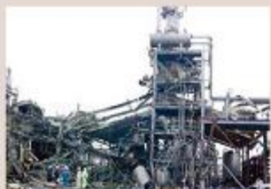
2000年 群馬県の化学工場におけるヒドロキシルアミン爆発事故 Hydroxylamine explosion at a chemical plant in Gunma Prefecture in 2000
