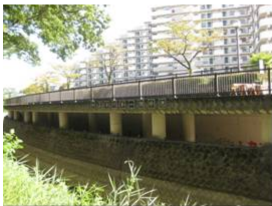
圖 36 妙正寺川第一調節池
