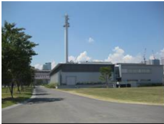
圖 56 東京臨海廣域防災公園本部大樓外觀
