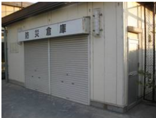
圖 82 堀切二丁目防災公園—防災倉 庫
