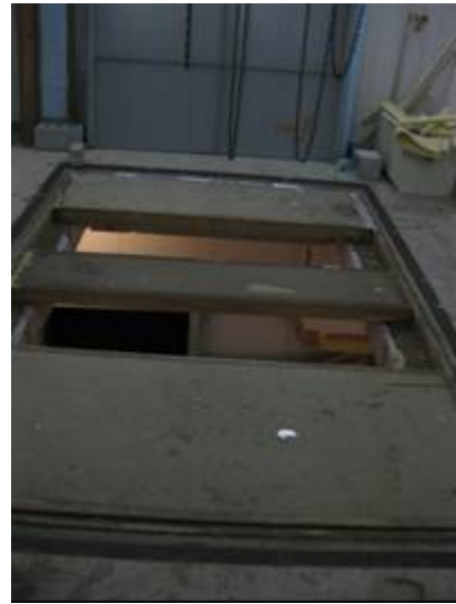
圖 23 建築總合試驗所—樓板衝擊音實驗裝置
