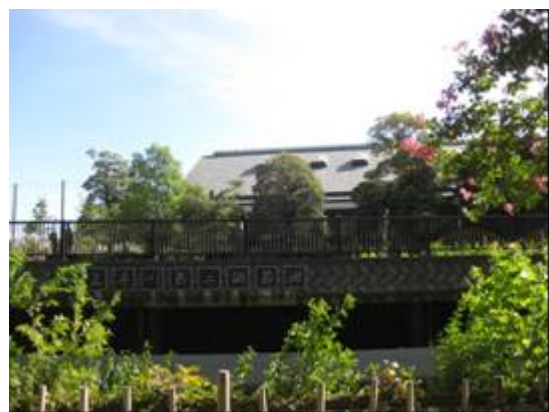
圖 37 妙正寺川第二調節池
