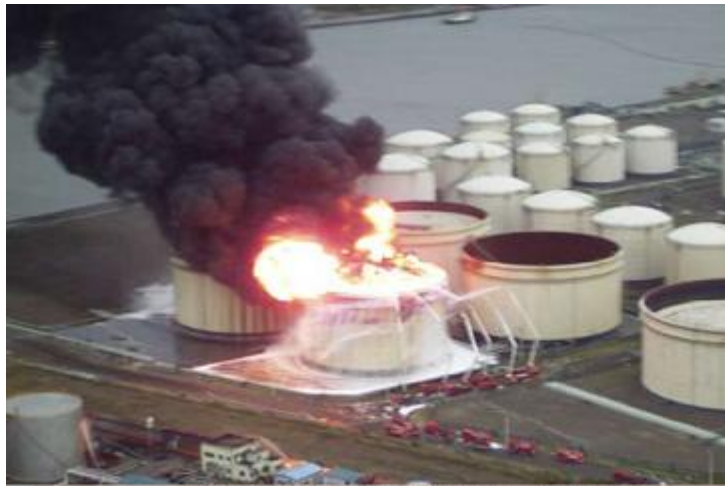
2003年十勝沖地震により苫小牧市の製油所で発生したナフサタンクの全面火災 Full-surface fire in an oil refinery's naphtha tank in Tomakomai after the 2003 Tokachi-oki earthquake
