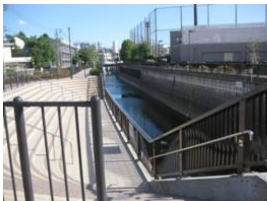
圖 41 妙正寺川沿岸調節池
