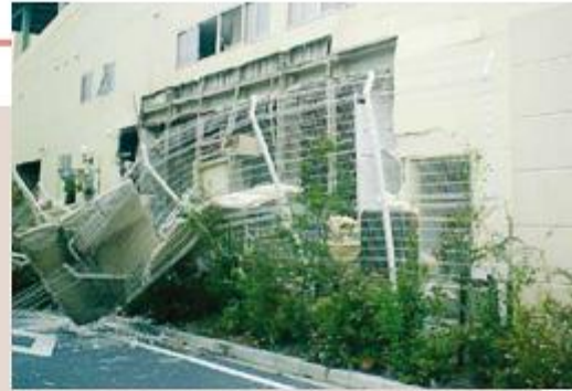
2003年 神奈川県における生ゴミ処理設備での爆発事故 Explosion at raw garbage treatment facility in Kanagawa Prefecture in 2003
