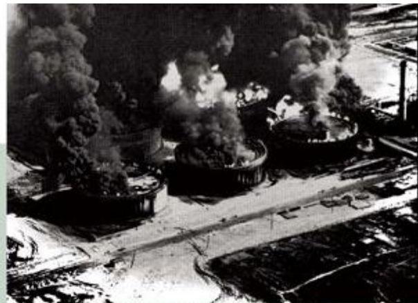
1964年 新潟地震の際の新潟市の製油所における石油タンク火災 (写真提供: 防衛省) Oil tank fire at a refinery in Niigata following the 1964 Niigata earthquake (Photo provided by courtesy of the Ministry of Defense)
