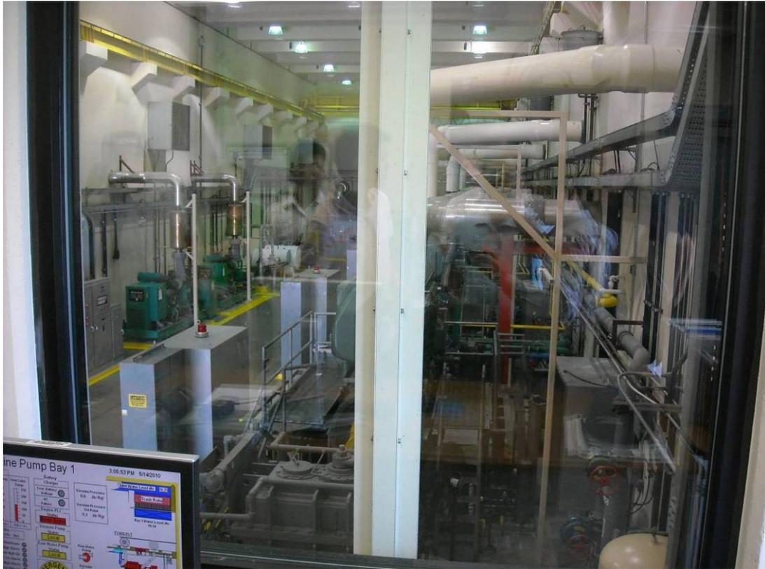
圖 4-5 污水引入人工溼地之抽水站室內設備
