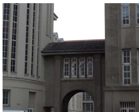
連接法院與監獄的空橋
