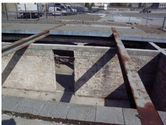
地下儲物倉庫改建的牢房
